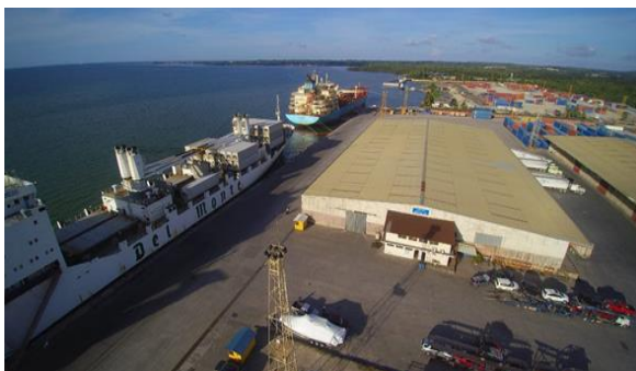
Puerto de Santo Tomas de Castilla de Guatemala, dentro de la Reserva Protectora de Manantiales Cerro San Gil y la Zona de Veda Definitiva Santo Tomas de Castilla.
