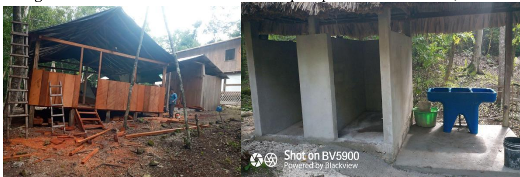
Imagen 44. Construcción de infraestructura para personal en El Jabalí, PNMYA.
